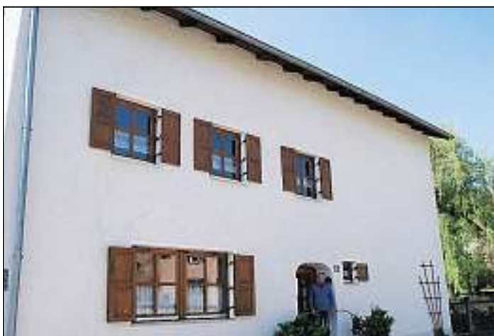
Zufrieden und stolz: Lothar Lanzhammer hat mit seiner Frau Anita die Kastlmühle saniert. Fotos: Sturm
